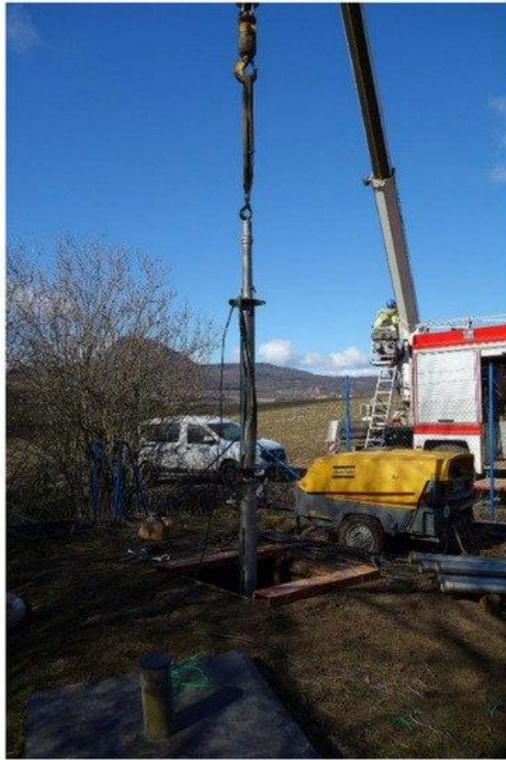
Abbildung 7. Im Rahmen des Projekts gebautes Sanierungsset.
